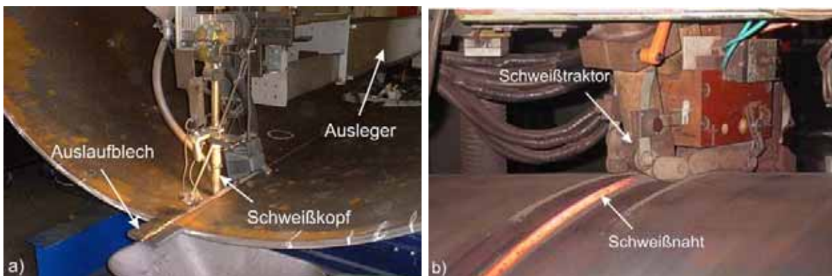
Bild 2.10: a) UP-Längsnahtschweißung an einem Rohrschuss b) UP-Umfangnahtschweißung
