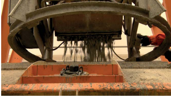
Abbildung 161 Befüllen der Schalung (1/2)
