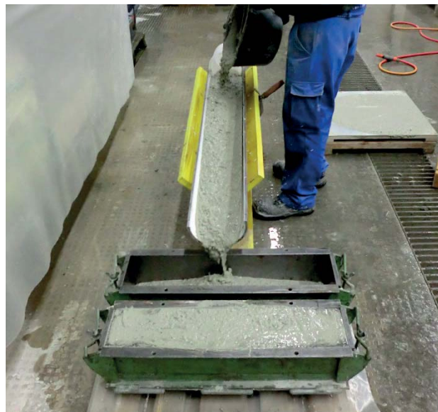
Abbildung 99 Betonage der Balkenform über die Rinne in die Mitte der Form
