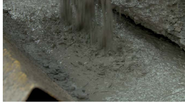
Abbildung 162 Befüllen der Schalung (2/2)
