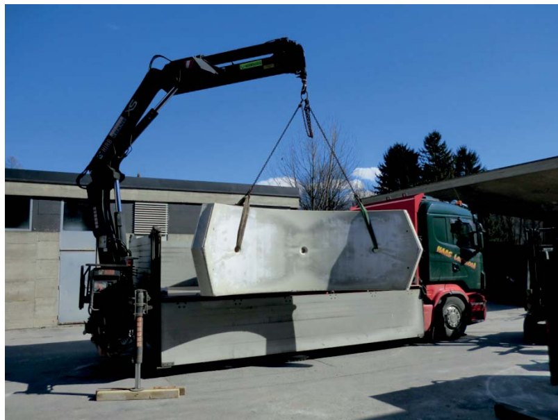
Abbildung 165 Abladen der Tübbinge
