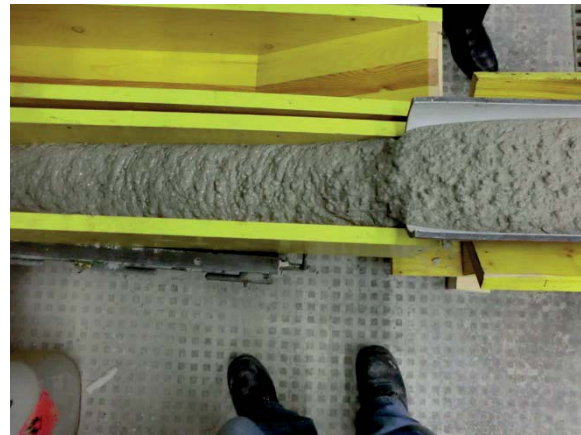
Abbildung 107 Betonage dieser Balken
