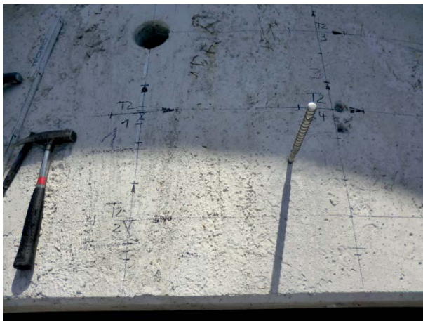
Abbildung 168 Markierung vor der Bohrkernentnahme
