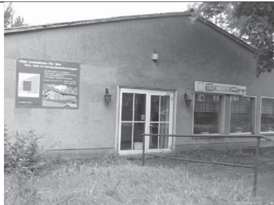
Abbildung 4 Geschlossenes Lebensmittelgeschäft in Gültz, das in Mietwohnungen umgewandelt werden soll.
