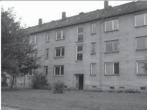
Abbildung 10 Zum Rückbau vorbereiteter Geschossbau in Groß Luckow (Vorpommern)
