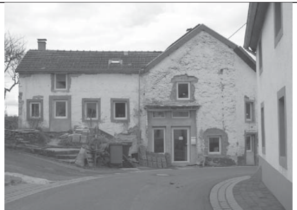
Abbildung 13 In Renovierung befindliches Haus in Mael (Westeifel)
