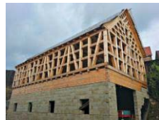
شكل (4): الهيكل الخشبي لسقف بيت قيد البناء
