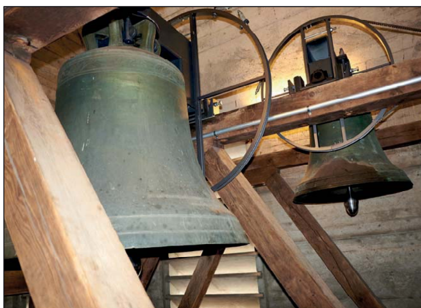
Abbildung 9: Neue Glockenjoche mit mittlerer Abkröpfung und Fallklöppeltechnik
