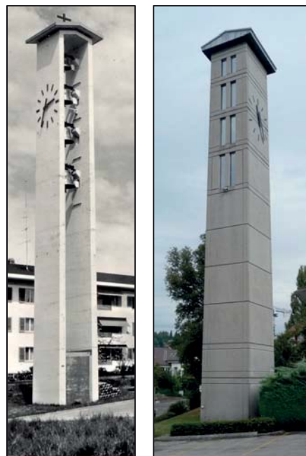
Abbildung 20: Ein offen konzipierter Glockenturm, links im Original, rechts nach einem aufwendigen, primär um der Schallpegelsenkung willen durchgeführten Umbau. – linkes Foto Gemeindearchiv Lyss (Schweiz)
