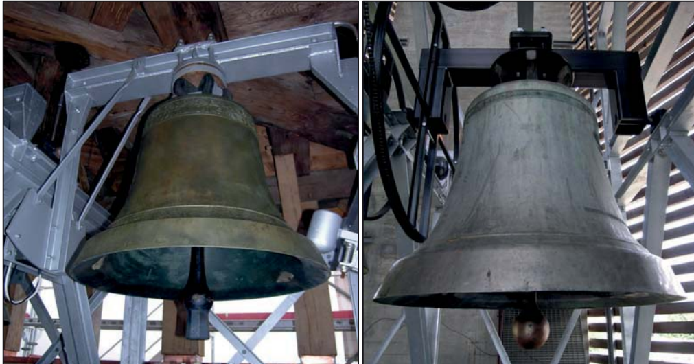
Abbildung 22 links: Eine bereits 1947 an gekröpften Jochen installierte Glockenanlage nach der Sanierung und der Neuausstattung durch Fallklöppel. Da im Vergleich zu Abb. 21 der Schwungrhythmus nicht verlangsamt wurde, ist die Klangwirkung vom Läuten am geraden Joch kaum mehr unterscheidbar; Rechts: Eine der vielleicht ersten Anlagen, die 2017 durch die Umstellung von geraden auf gekröpfte Joche und dank präzise abgestimmter Fallklöppel sogar wesentlich an Klangfülle und Schönheit gewonnen hat.
