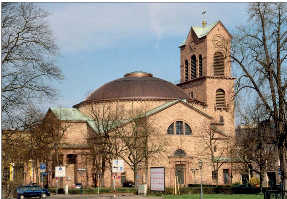
Abbildung 18: Karlsruhe, St. Stephan. Beispiel eines Turmes, bei dem die Schallfenster zugunsten angenehmer Klangwirkung zu Recht verhältnismäßig dicht durch Holzjalousien geschlossen sind. – Bild: Wikimedia commons.
