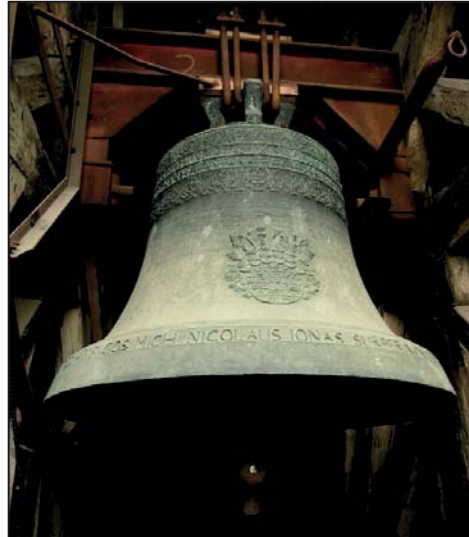
Abbildung 2: Weimar, Schlossturm, Glocke gis° von 1712 am gekröpften Stahljoch aus der Nachkriegszeit
