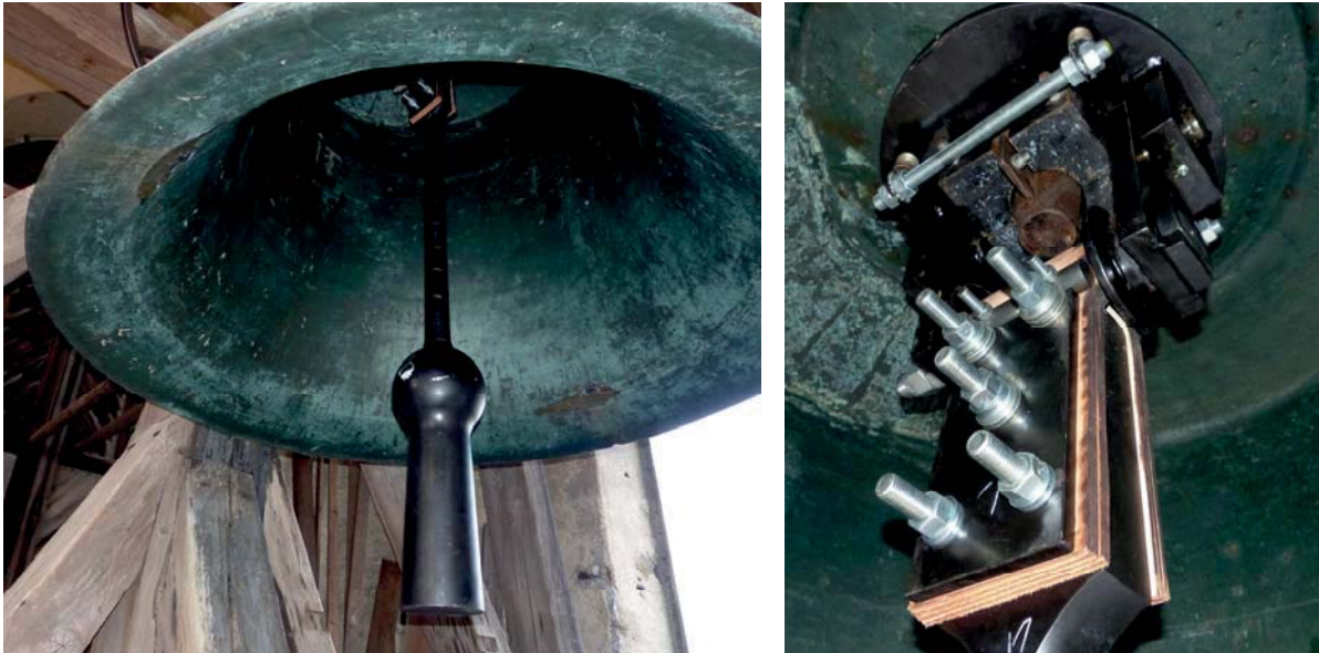
Abbildung 13: Der neue Klöppel für die große Glocke von St. Florian (links) mit Doppelgelenkaufhängung (rechts)
