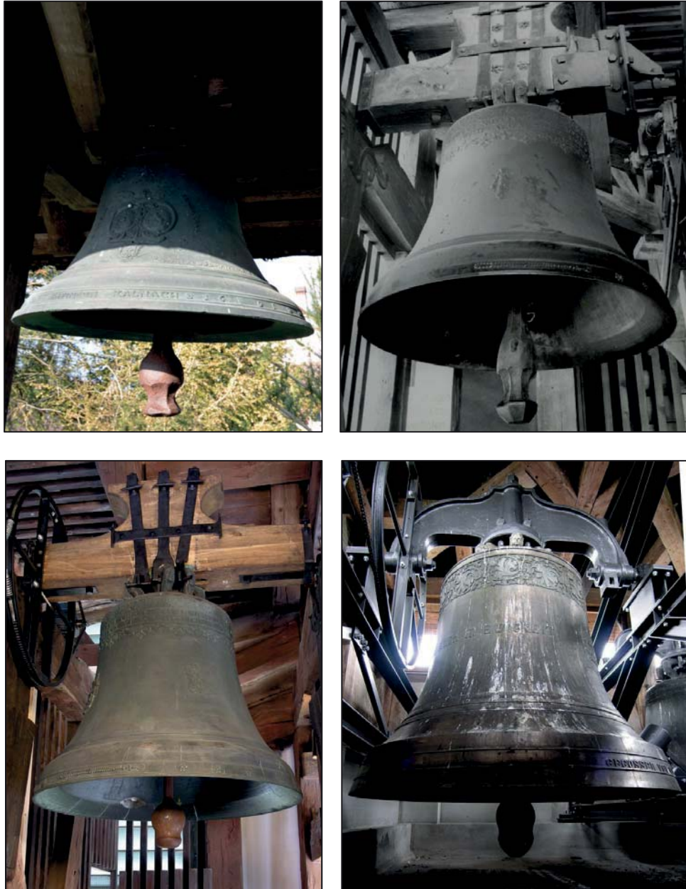
Abbildung 15: Zwei unterschiedliche, aber typische historische Klöppel vorindustrieller Zeit, (oben) die, ohne als konkretes Vorbild genutzt worden zu sein, in ihren Form- (und Klang-) Eigenschaften jüngsten mit ProBell und Experten vervollkommenen Erzeugnissen (zwei Beispiele unten) sehr ähnlich sehen (Foto oben rechts: Ernst Schiess, Bern, um 1940)
