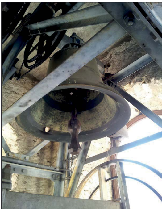
Abbildung 3: Im Zuge diverser Optimierungen wurden seit den 1980er Jahren vermehrt zahlreiche mit Stahlarmaturen versehene Geläute (links) neu ausgerüstet und die Schallfenster durch dichte Holzlamellen und Reflexionsbretter geschlossen, sozusagen das Ganze „warm eingepackt“ (rechts)
