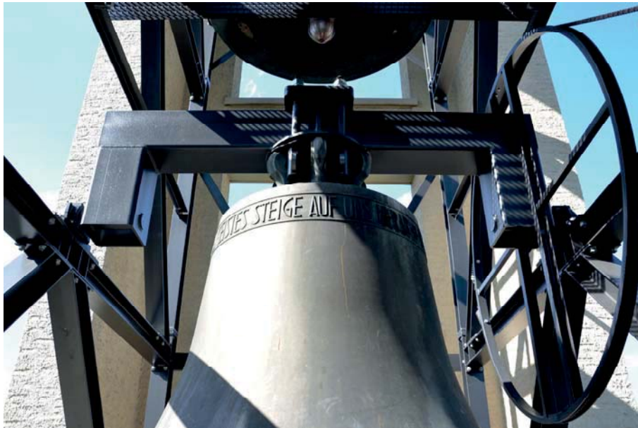
Abbildung 7: Glockenjoche für dualen Einsatz für Flug- und Fallklöppel
