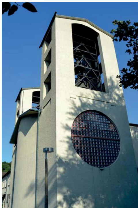
Abbildung 5: Blick auf die Stahlglockenstühle nach der Sanierung
