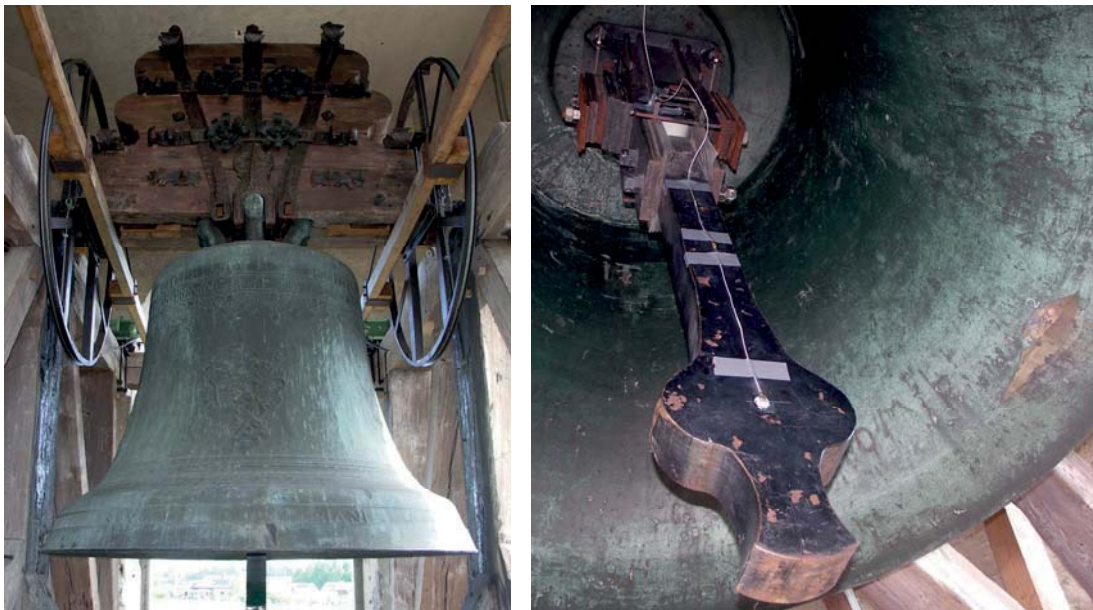
Abbildung 12: Die große Glocke von St. Florian (links) mit dem alten Gegengewichtsklöppel in Scheibenform (rechts)
