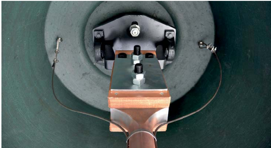
Abbildung 3: Doppelgelenkaufhängung hier mit Klöppelabsturzsisicherung bei offenen Glockentürmen
