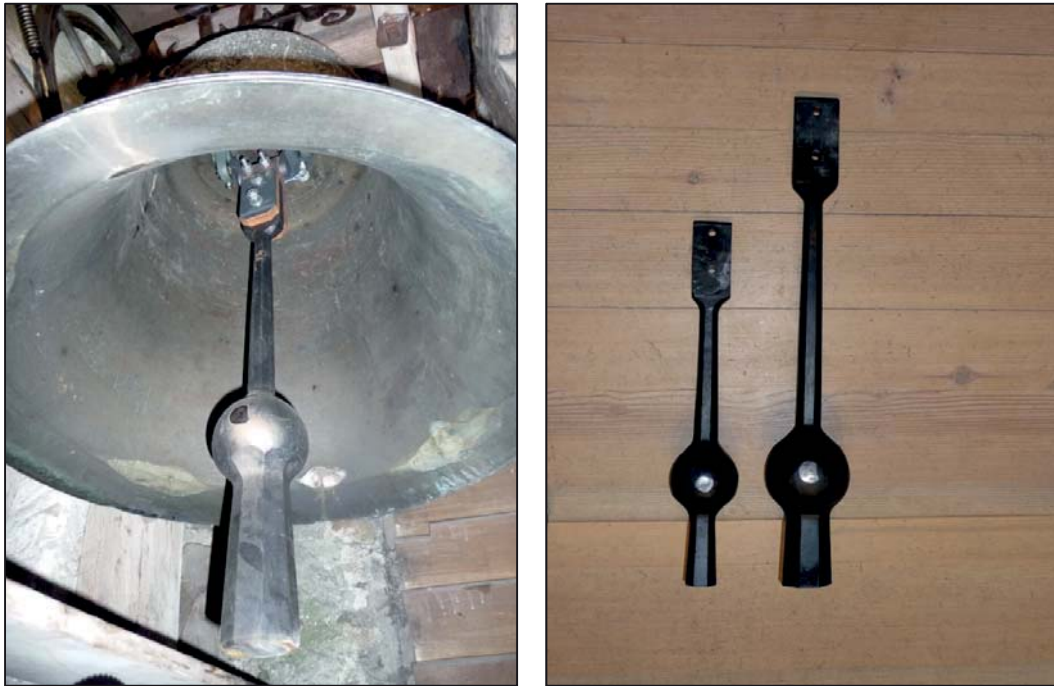
Abbildung 16: Links Klöppel mit langem schweren Vorschwung im Original. Rechts derselbe nach einer Einkürzung, die nicht nur die Klangwirkung verschönerte, sondern trotz der Verkürzung noch keine Erhöhung des Läutewinkels erforderte
