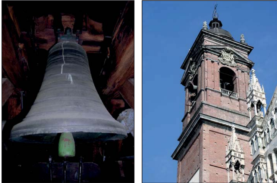
Abbildung 24: Zuckerhutglocke mit passendem hochlastigem Klöppel, dem bereits anzusehen ist, dass er die Glocke auch bereits bei geringem Lätewinkel anschlägt (links); Die Glocken des Domes zu Monza bei Mailand. Nicht nur dank dem gelungenen Guss, sondern auch dank der vergleichsweise hohen Gestalt und dem entsprechend kurzen, hochlastigen Klöppel entsteht trotz der völlig offenen Aufhängung nicht der Eindruck plärre (rechts)
