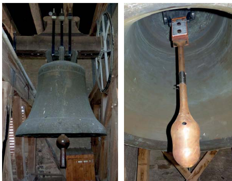
Abbildung 16: Die Hosanna im Münster Mittelzell vor der Sanierung (links) und der neue Klöppel nach der Sanierung (rechts)
