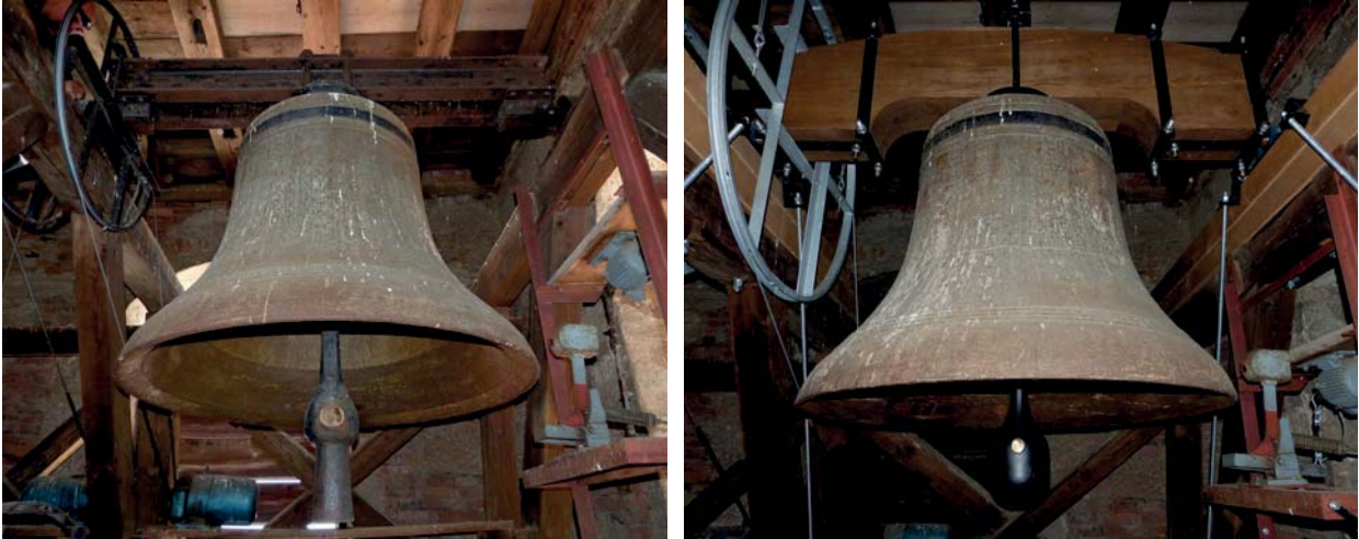
Abbildung 5: Glocke 3 vor (links) und nach der Sanierung (rechts)
