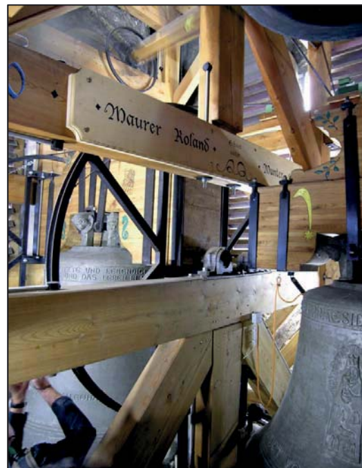
Abbildung 3: Im Zuge diverser Optimierungen wurden seit den 1980er Jahren vermehrt zahlreiche mit Stahlarmaturen versehene Geläute (links) neu ausgerüstet und die Schallfenster durch dichte Holzlamellen und Reflexionsbretter geschlossen, sozusagen das Ganze „warm eingepackt“ (rechts)
