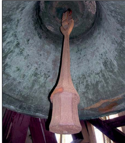
Abbildung 9: Historischer, musikalisch vorzüglicher Klöppel mit sehr effektiver Massenwirkung
