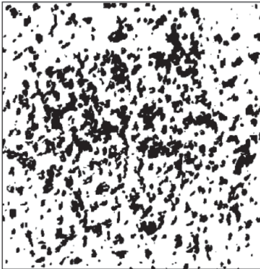
Kennwert 3,5 geschädigte Fläche 29,0 %
