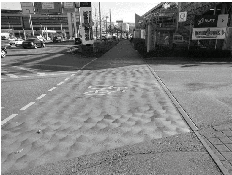
Abb. 6 Flächige Einfärbung einer Radwegfurt in Stuttgart
