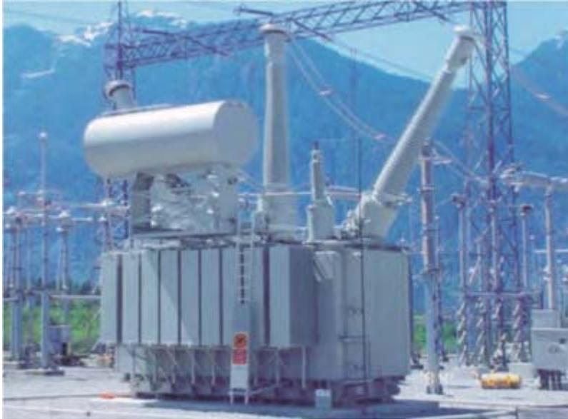
**Abbildung 2.3** Blindleistungskompensations-Drosselspule 150 Mvar [4]
