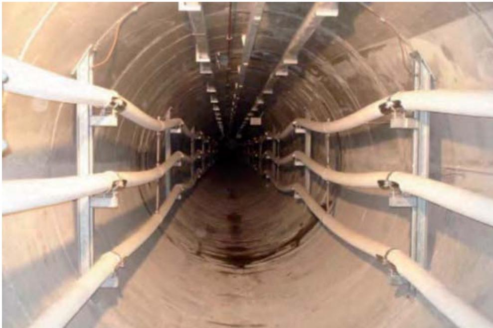
**Abbildung 1.20** 380-kV-Kabelanlage in Berlin
