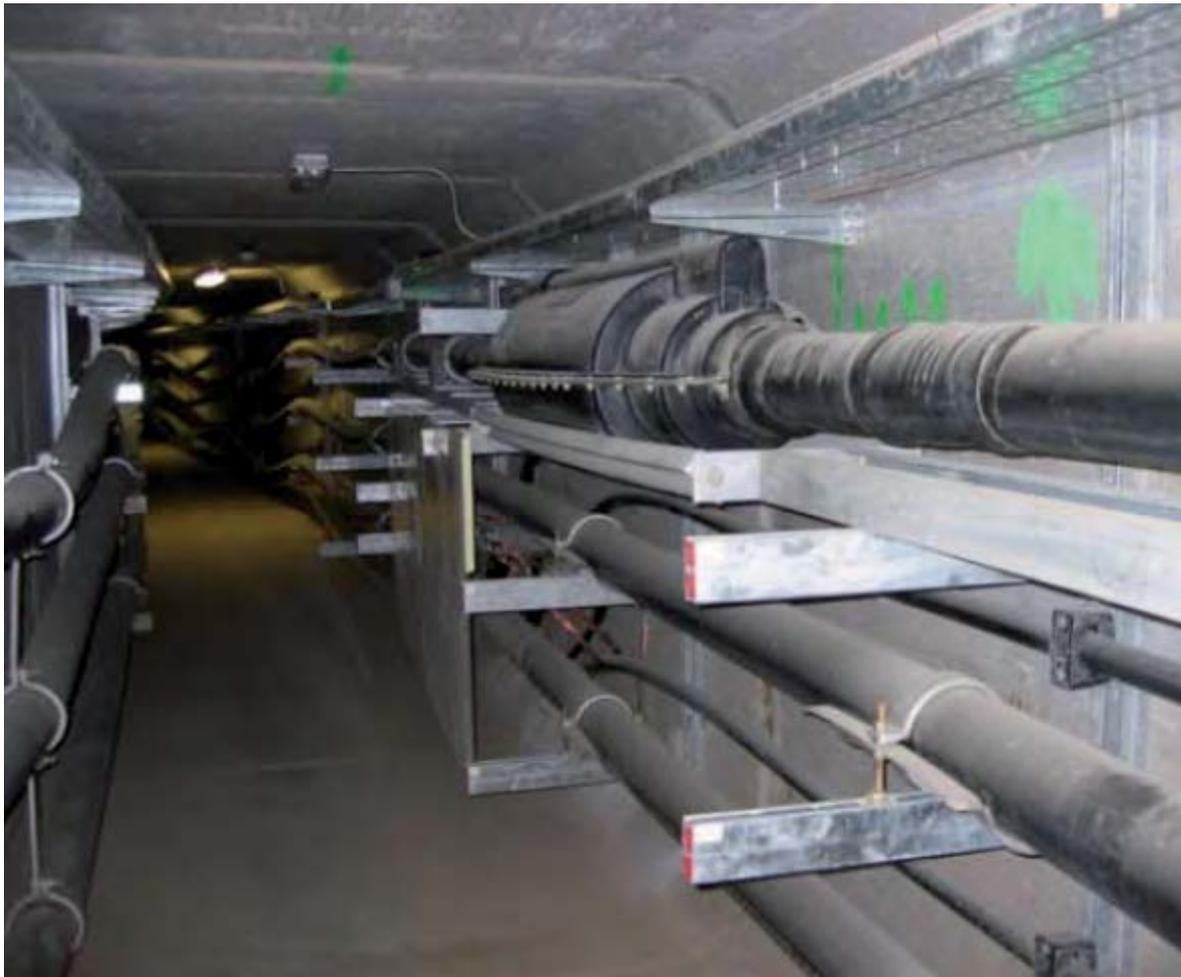
**Abbildung 1.16** 380-kV-Tunnelbauwerk mit Kabelmuffe, Flughafen Madrid. [16]
