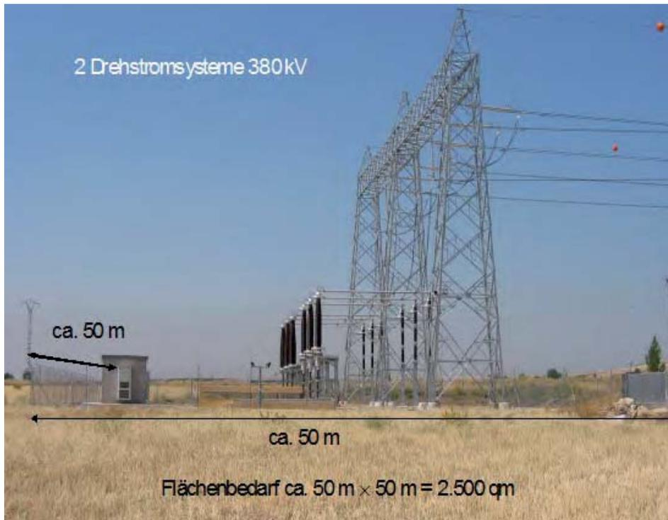
**Abbildung 1.24** Freileitung-Kabel-Übergangsanlage mit geschätzten Abmessungen, Beispiel Madrid.
