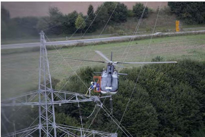
**Abbildung 6.1** Anbringen von Erdseilmarkierungen mit einem Hubschrauber [5]
