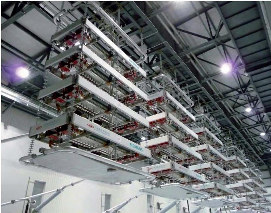
**Abbildung 1.29** Stromrichterventiltürme einer Konverterstation [29]
