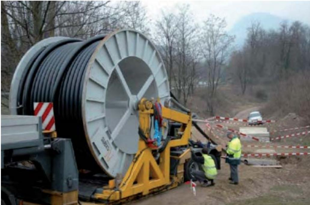
**Abbildung 1.19** Kabelzug bei einem 380-kV-Kabel (630 mm<sup>2</sup>, 560 MVA) Mendrisio Cagno [21]
