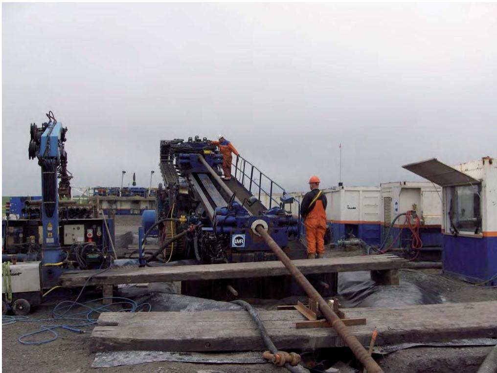
**Abbildung 1.21** HDD-Bohrung [5]
